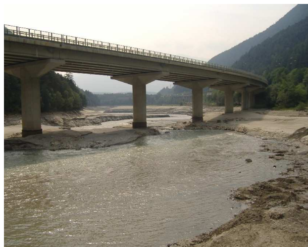
Abbildungen 1/2. Stauee Franzensfeste während der Entfernung abgelagerten Materials aus dem Stauraum. Links Juni 2009 und rechts 2006.
