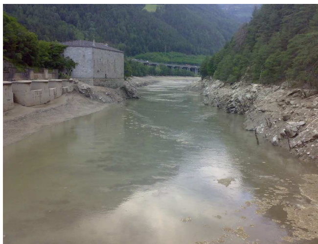
Figure 1/2. Serbatoio di Fortezza durante le operazioni di sfangamento/sghiaimento effettuate nei mesi di giugno 2009 (a sinistra) e 2006 (a destra).
