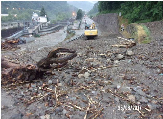
Abbildungen 1. und 2 Mure verlegt SS12 am Villnösser Stausee (links). Erodierter Seitengraben nach Murgang (rechts).
