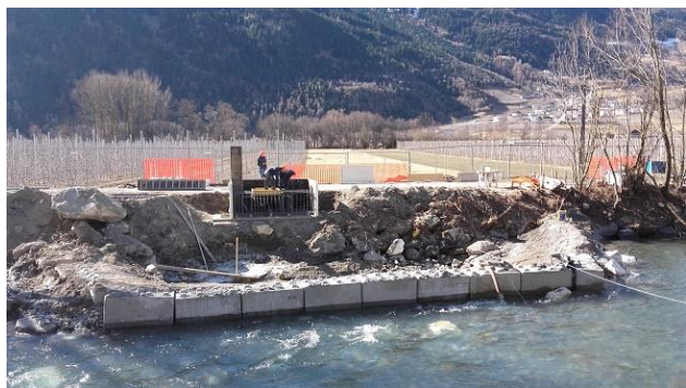
Abbildungen 1. und 2. Errichtung der neuen Pegelstation Eyrs (links in der Bauphase und rechts nach der Fertigstellung).
